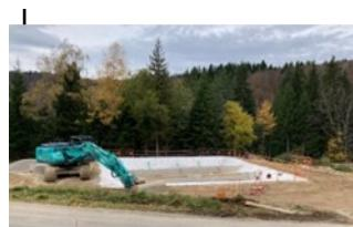
particulier, il s'agissait de ne pas dépendre de dispositifs couteux et énergivores comme des pompes de relevage ou d'une augmentation importante de la longueur du réseau de canalisations qui auraient amené les effluents à un seul endroit si le choix s'était porté sur une seule station de traitement.
