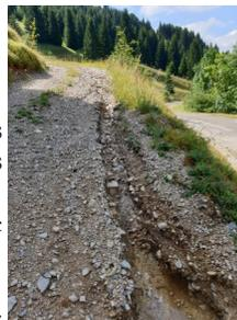
Le chemin de Petite Combe est celui qui avait subi le plus de dégâts. Cette voie s'est trouvée complètement ouverte par une tranchée de 1 mètre de large et plus d'1 mètre de profondeur. Nous avons rétabli le passage le plus vite possible et envisagé à l'époque qu'au printemps 2020 une intervention plus importante serait menée. Ce fût chose faite avec la réalisation d'une tranchée, et la pose d'une buse au diamètre plus important afin de ne pas être saturé en cas de gros orage.
